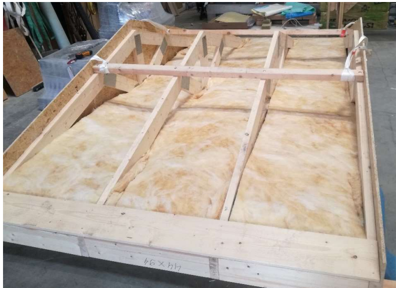
Abb. 4: Aufgebautes Nagelplattenbinder-Dachsystem mit angebrachter Unterdecke und eingebrachter Gefachdämmung
