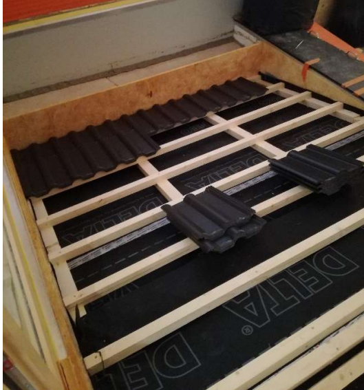
Abb. 7: Im Dachrahmen eingebautes Nagelplattenbinder-Dachsystem mit Eindeckung (senderraumseitig)
