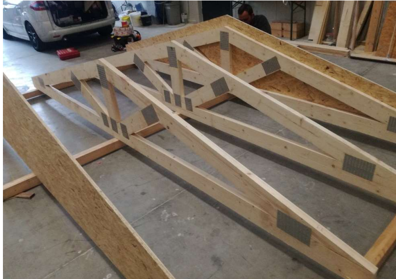
Abb. 3: Aufgebautes Nagelplattenbinder-Dachsystem
