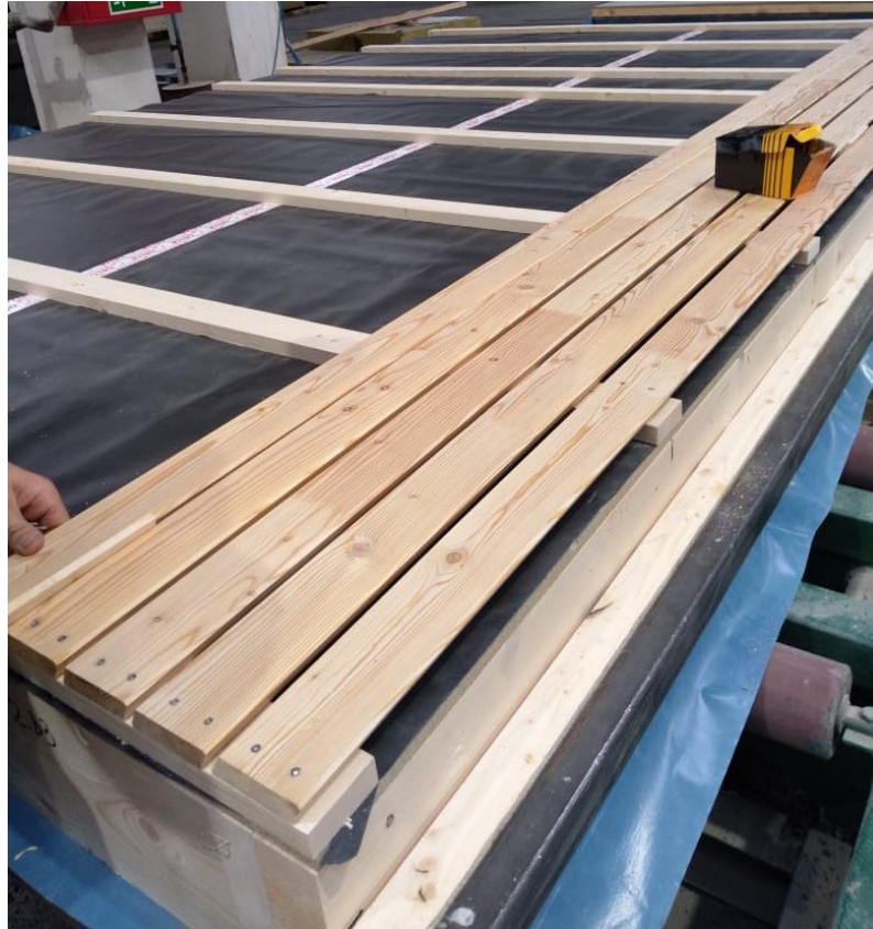
Abb. 10: Montage der Rhombusschalung (senderaumseitig) von AW02 (Bild von Auftraggeber)
