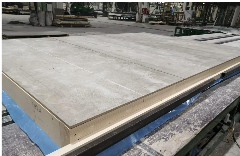
Abb. 8: Senderraumseitiges Beplanken der Holzrahmenwand am Beispiel von AW01 (Bild von Auftraggeber)
