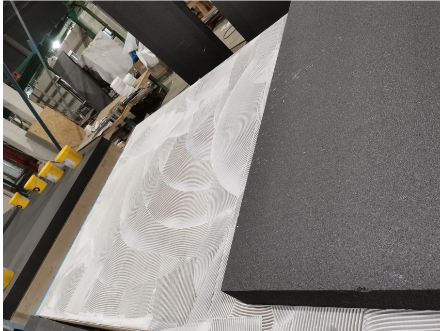
Abb. 9: Aufkleben des EPS-F für das WDVS am Beispiel von AW01 (Bild von Auftraggeber)
