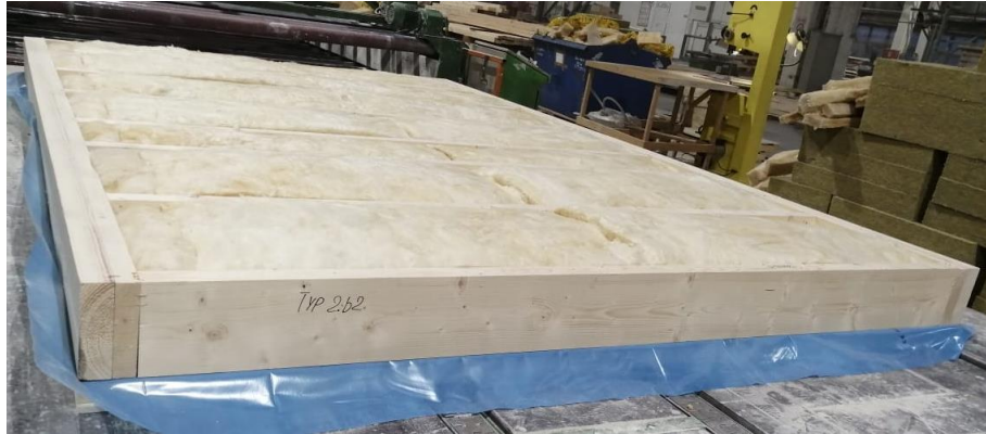
Abb. 7: Einbringen der Gefachdämmung in den gedrehten, empfangsraumseitig bereits beplankten Holzrahmen am Beispiel von AW01 (Bild von Auftraggeber)
