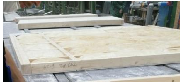
Bild 5.8: Einlegen der Dämmung in die Unterkonstruktion.
