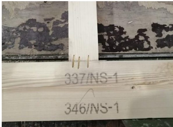
Bild 5.3: Klammerverbindung Ständer – Schwelle/Rähm.
