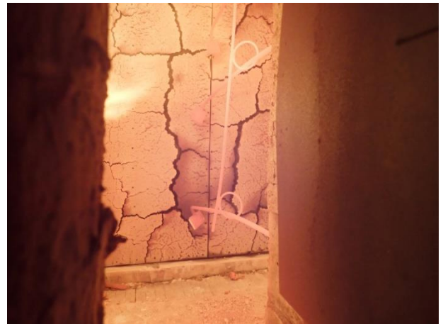
Bild 6.4: Prüfminute 16 – Risse öffnen sich und Platten der äußeren Lage stehen ab.
