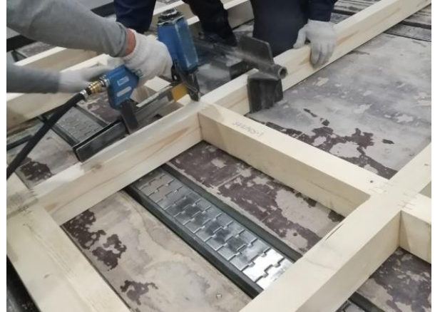
Bild 5.4: Klammerverbindung Ständer – Querriegel.
