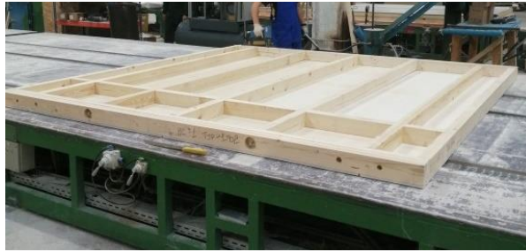
Bild 5.7: Ansicht Tragkonstruktion mit Beplankung feuerabgewandter Seite.
