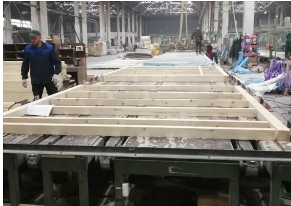
Bild 5.1: Montage der Holständer-Unterkonstruktion.
