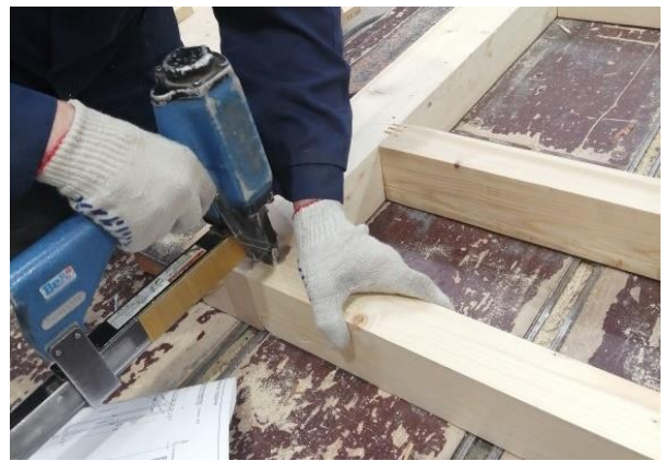
Bild 5.2: Montage der Holständer-Unterkonstruktion.
