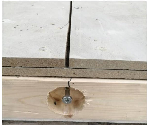
Bild 5.10: Montage der äußeren Plattenlage und Befestigung mit Schrauben, feuerzugewandte Seite.
