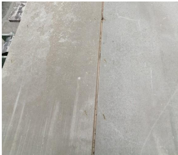
Bild 5.9: Montage der inneren Plattenlage und Befestigung mit Klammern, feuerzugewandte Seite.
