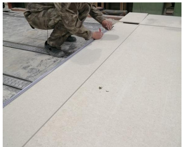
Bild 5.6: Montage der Gipsfaserplatten, feuerabgewandte Seite.
